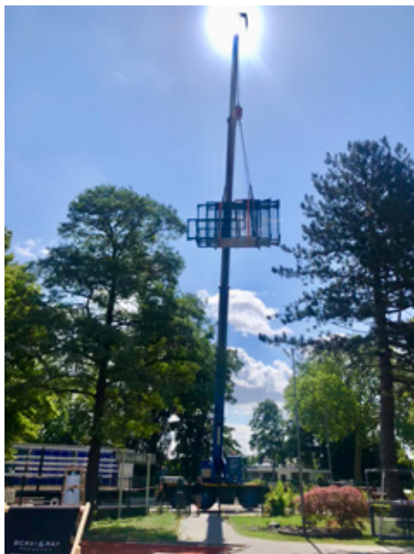
Ende Juli 2023 war es soweit: Die neuen Padelplätze wurden angeliefert.
